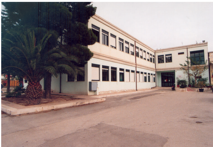
...successivamente si realizza il Piano Terra della stessa ala.
